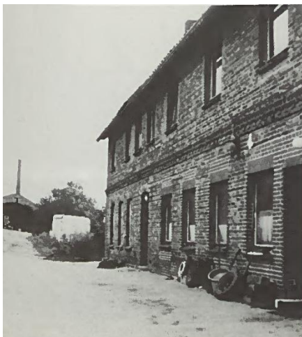
Zieglerwohnhaus auf der alten Ziegelei in Barnkrug (Quelle: Gut Brand, S. 63)
