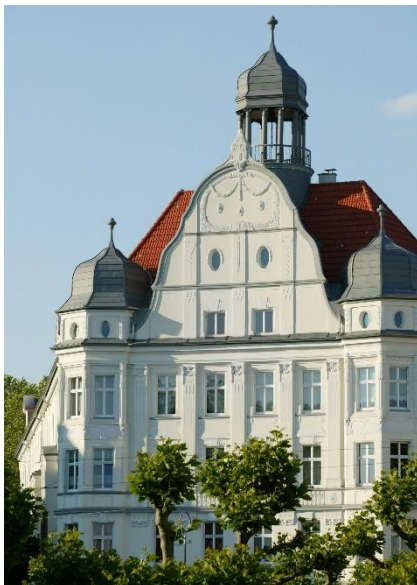
Bild 6: Ziegelbau mit Verputz, ehem. Stadtparkassengebäude am Borsigplatz in Dortmund
